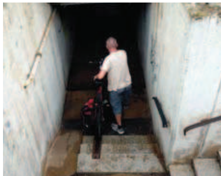
Nicht barrierefrei begehbare Unter- und Überführungen
