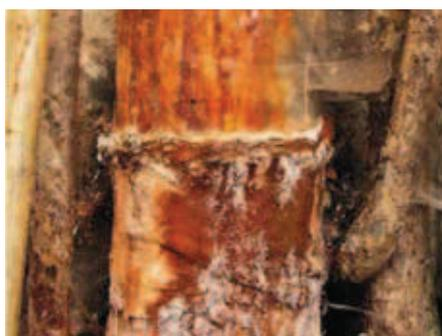
**Abb. 6: Korrosion bleibt meist solange unbemerkt, bis die Leitung ein Loch hat oder bricht. ©Strabag und Fotolia**
