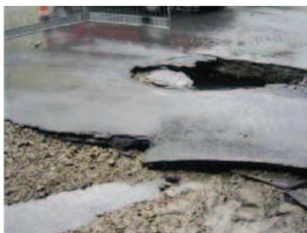
**Abb. 5: Bei großen Wasserrohrbrüchen unter der Straße spülen große Wassermengen mit viel Druck den Untergrund weg – die Straße darüber bricht. ©Strabag und Fotolia**
