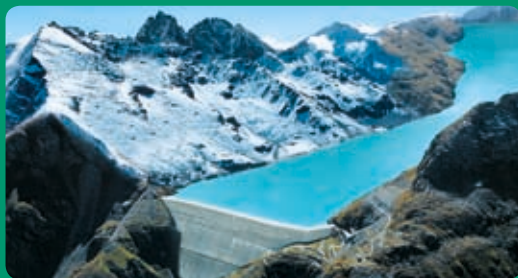
WASSERKRAFT als sauberer Stromlieferant
