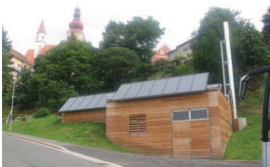
Das Biomasse-Heizwerk in Straden ist vorbildhaft.
