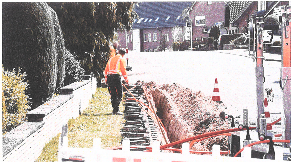
Grabungsarbeiten sind für bis zu 80 Prozent der Projektkosten beim Ausbau verantwortlich.
