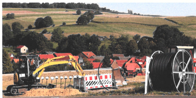
Noch bis Ende 2022 können Investitionen aus den Mitteln des Kommunalen Investitionsgesetzes finanziert werden.
